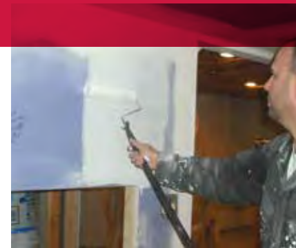
Applying primer to new drywall.
